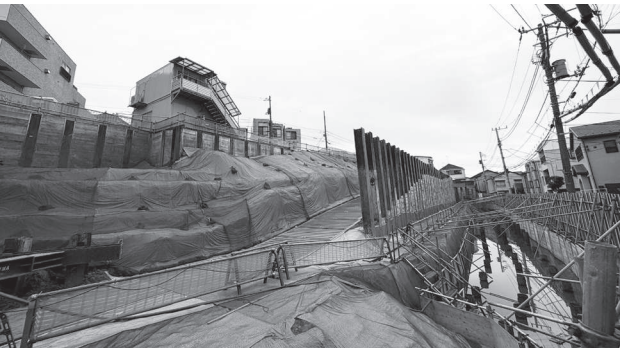
▷富ヶ谷一丁目建設地の様子
