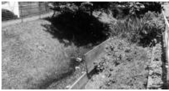
玉川上水の開渠部分
