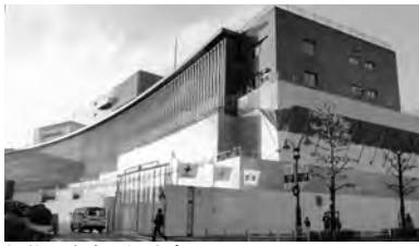
解体工事中の旧庁舎
