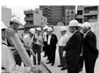
◁代々木八幡駅ホーム延伸工事視察
