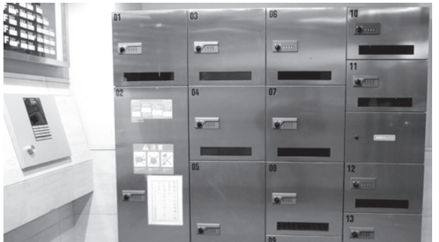
集合住宅の宅配ボックス
