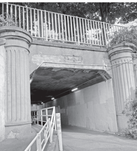
本村隧道南側杭門
