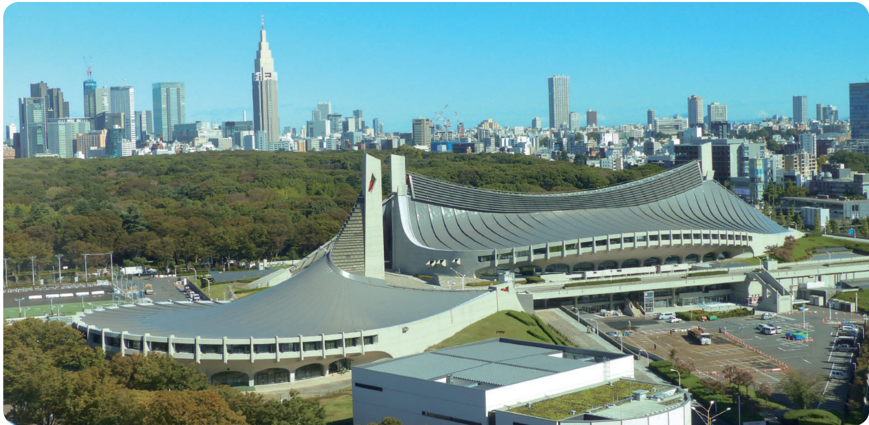
国指定重要文化財(建造物)に指定された国立代代木競技場
